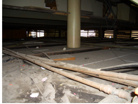
Figura 21 - Visualização próxima e a distância do acúmulo de pó sobre a cobertura dos setores
